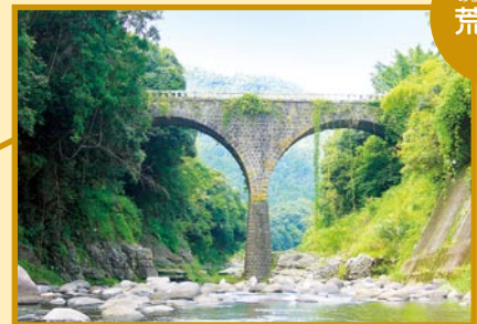
めがね橋(2連アーチ)として最も整った石橋
